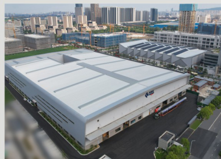
Ханчжоу 2 цех для производства оборудования обработки цветных металлов
