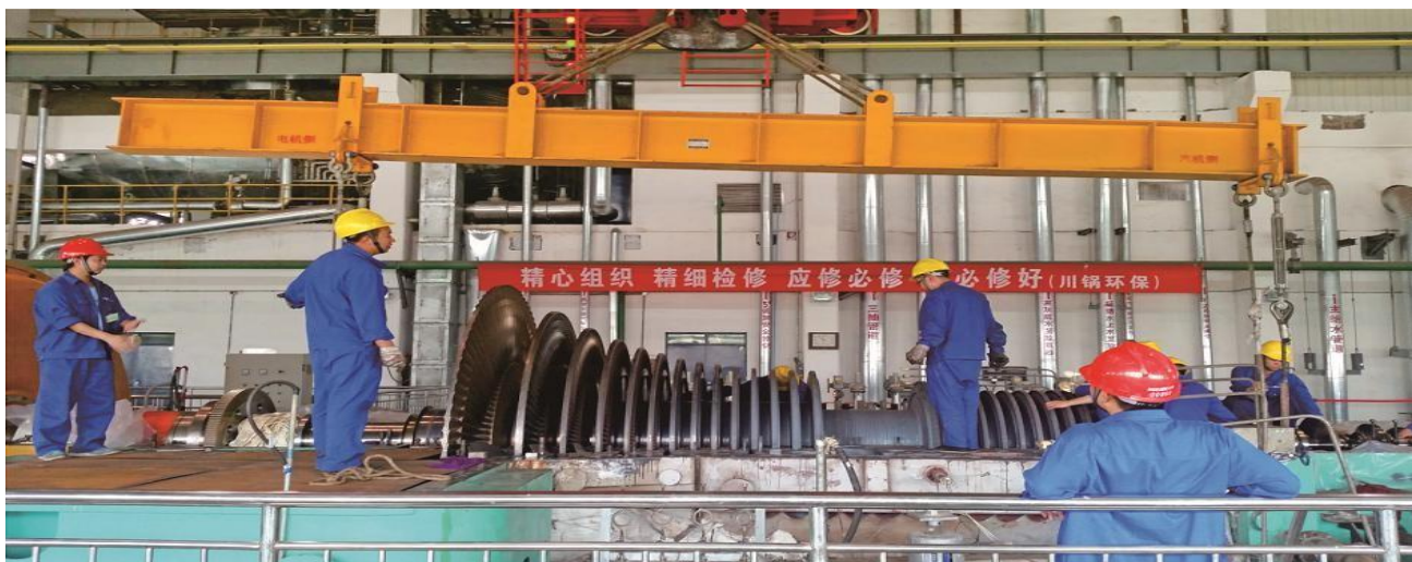
Проект технического обслуживания выработки электроэнергии мощностью 65 МВт в энергетическом центре «Цзяньлун» в Таншане
